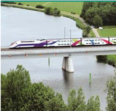
Transports et leurs infrastructures
